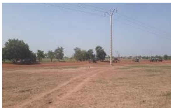
Photo 4 : route de Koutiaba et ligne MT
