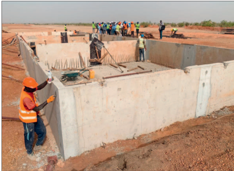
Avec le Projet eau et assainissement en milieu rural, l'Onas est en train de construire des infrastructures dans certaines villes secondaires.
