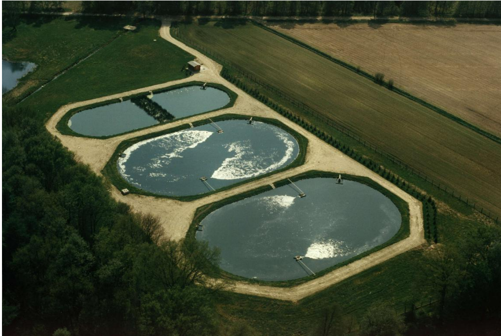
Figure.4 : Exemple d'un lagunage aéré
