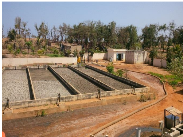
Figure 13 : Lits de séchages des boues
