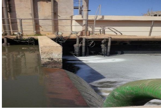
Figure 12 : Bassin de stockage
