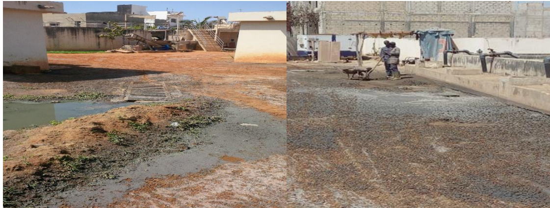
Figure 14 : Débordement des effluents
