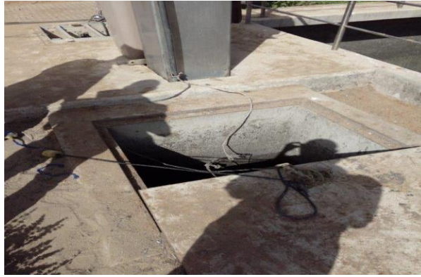
Figure 7 : Regard dégrilleur + Poste de refoulement
