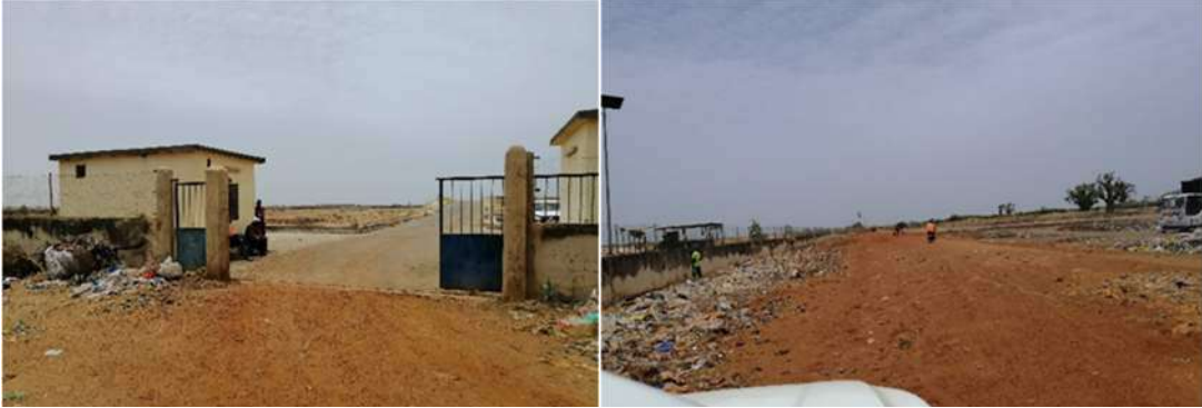
Entrée de la STBV sans signalisation, souvent inondée par les eaux de pluies, EDE, mai 2024
