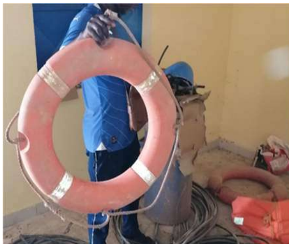
Bouée et les gilets de sauvetage en état de dégradation et non installée à côté des ouvrages, EDE, mai 2024
