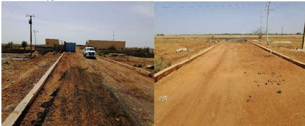
Entrée de la STBV sans signalisation de sortie/entrée camion, EDE, mai 2024
