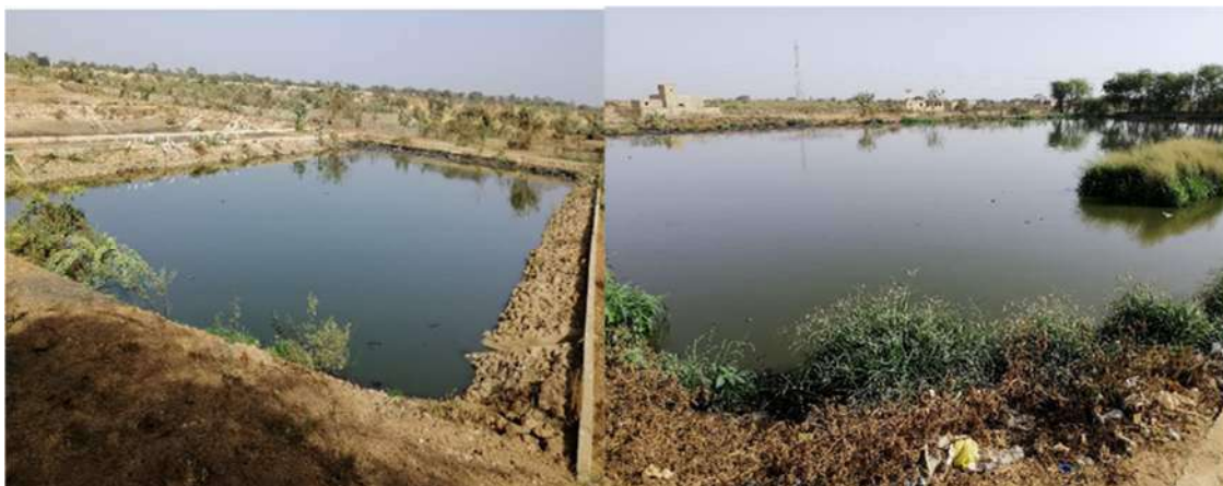
Vue du bassin "gamou" sans protection contre les risques de noyade, EDE, mai 2024
