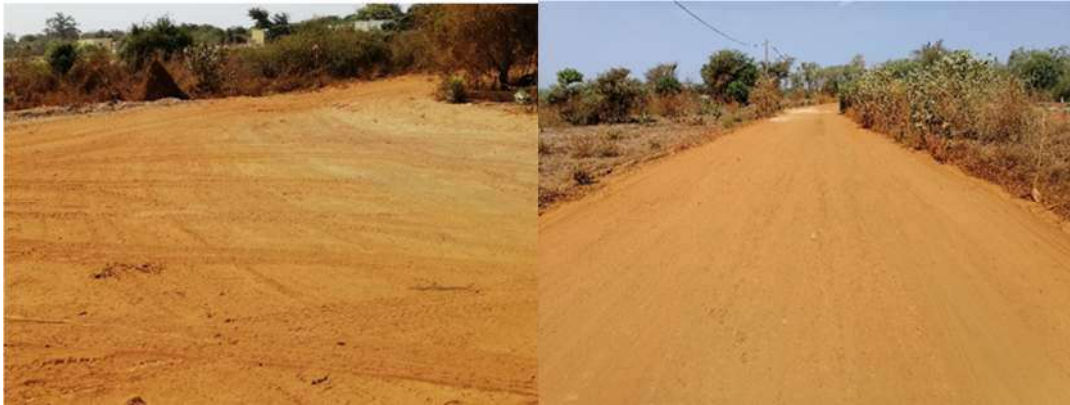
Entrée de la STBV sans signalisation, souvent inondée par les eaux de pluies, EDE, mai 2024
