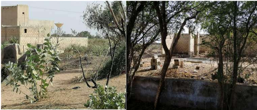
Quartier Ndindi à moins de 50 mètres de la station ("bassin gamou"), EDE, mai 2024
