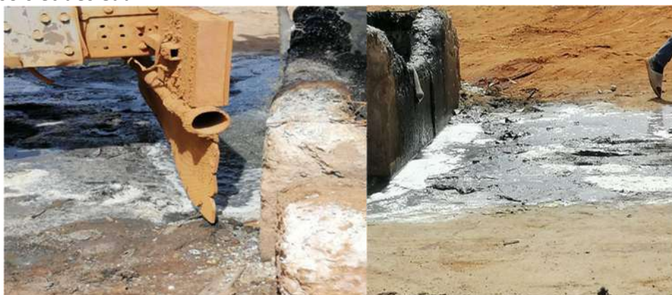
Déversement d'effluents, EDE, mai 2024
