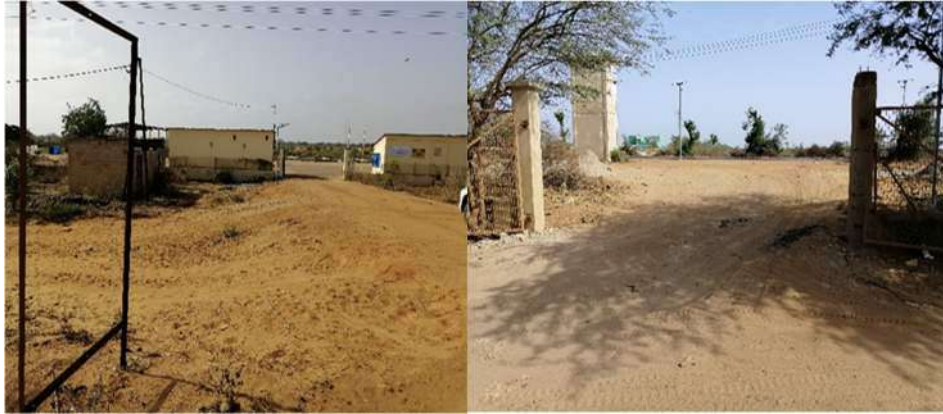
Entrée de la STBV sans signalisation, souvent inondée par les eaux de pluies, EDE, mai 2024
