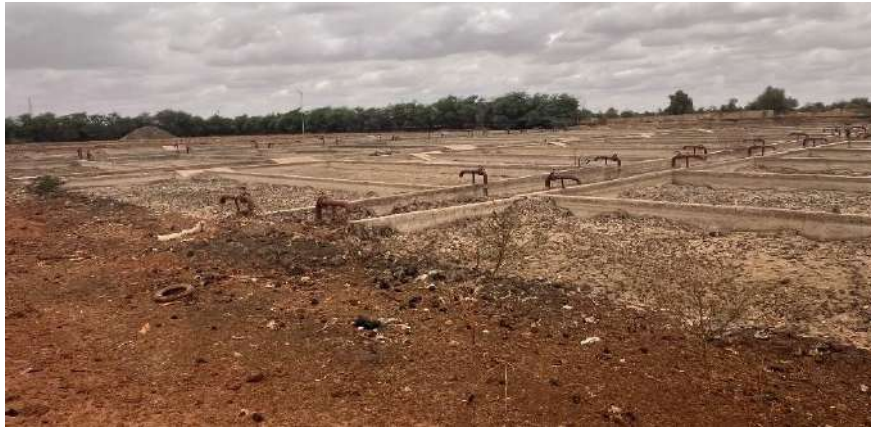
Photo 25 : Lits de séchage de la STBV de Touba
