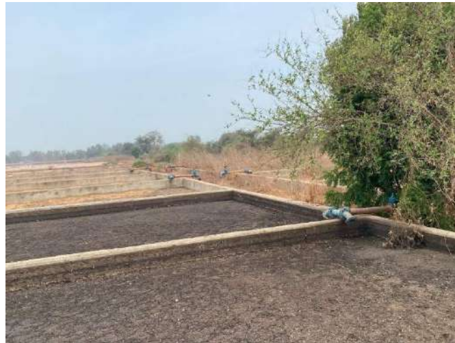
Photo 32 : Lits de séchage non plantés de la STBV de Mbour
