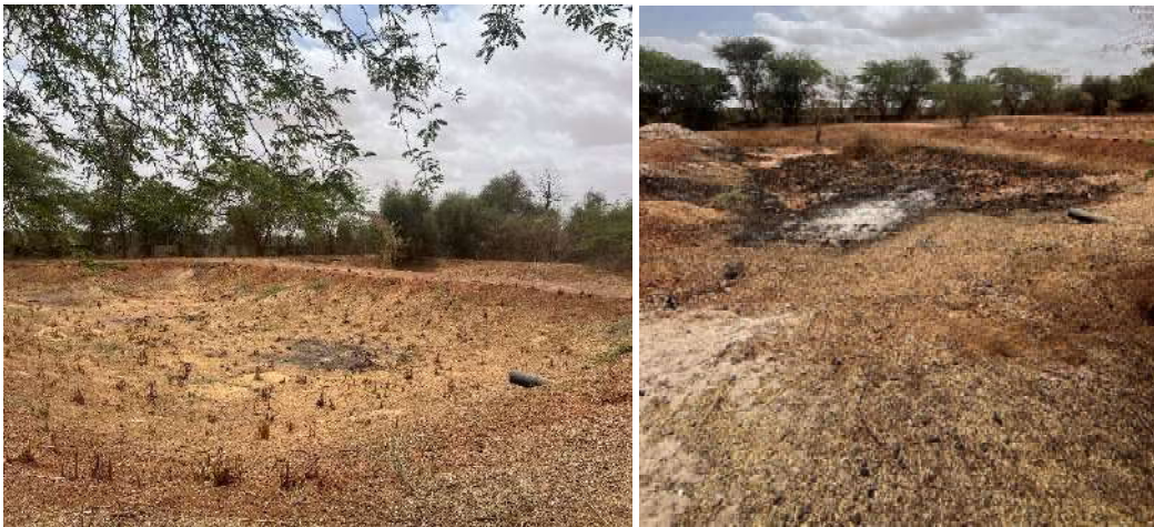
Photo 13 : Bassins d'infiltration de la STBV de Diourbel
