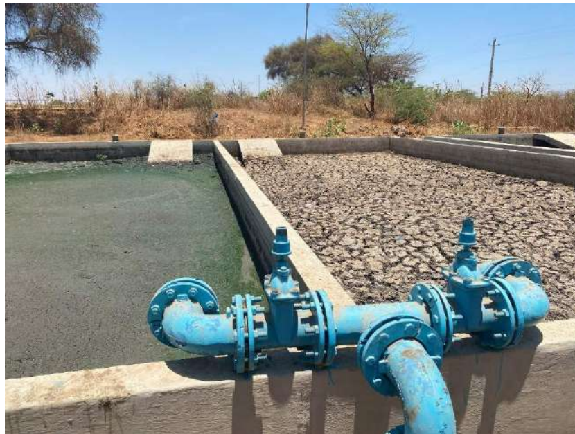
Photo 44 : Lits de séchage non plantés de la STBV de Louga
