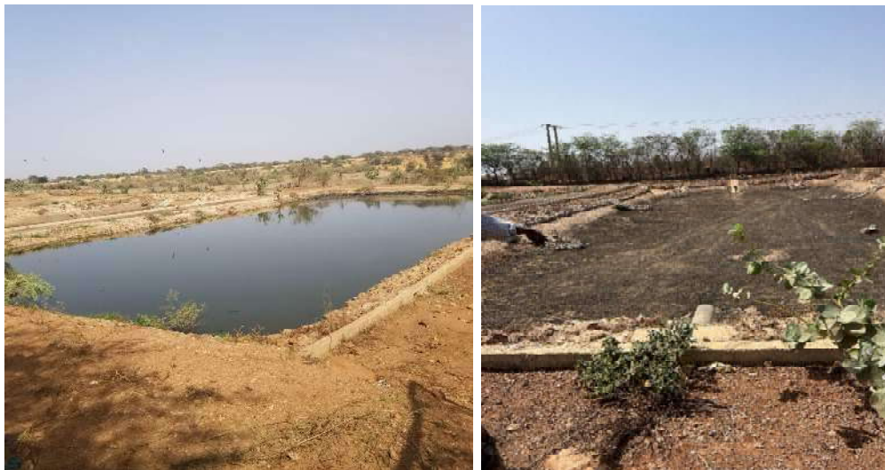
Photo 4 : Bassins d'infiltration de la STBV de Tivaouane
