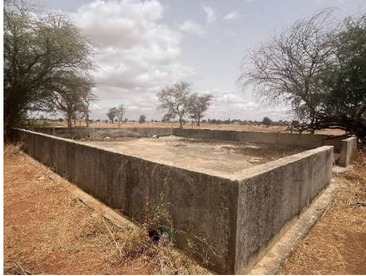
Photo 19 : Hangar de stockage des boues séchées de la STBV de Mbacké
