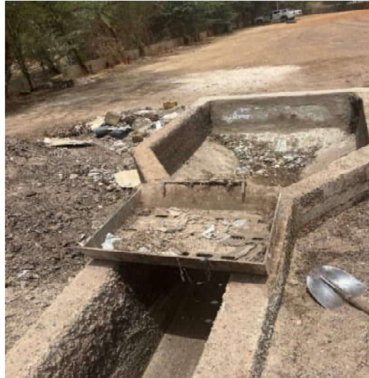
Photo 9 : Ouvrage de réception de la STBV de Diourbel
