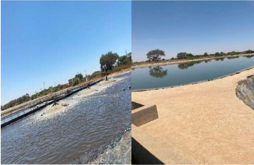
Photo 45 : Filière de traitement (lagunage naturel et aéré) de la STEP de Louga
