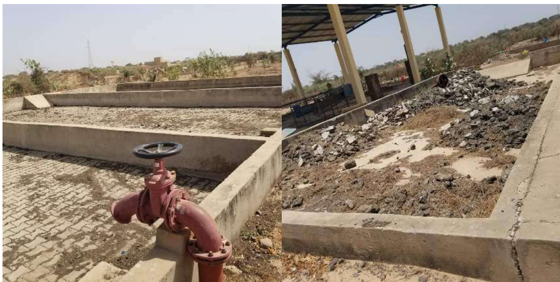
Photo 3: Lits de séchage non plantés en pavés de la STBV de Tivaouane
