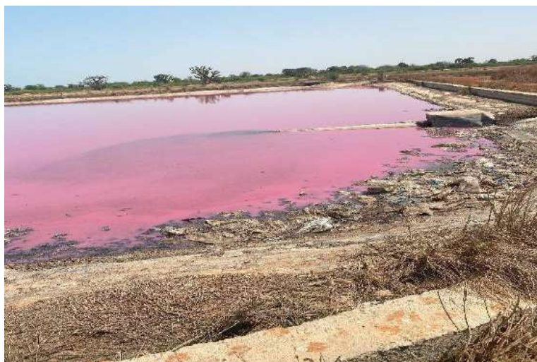
Photo 40 : Bassins de lagunage de la STEP de Joal
