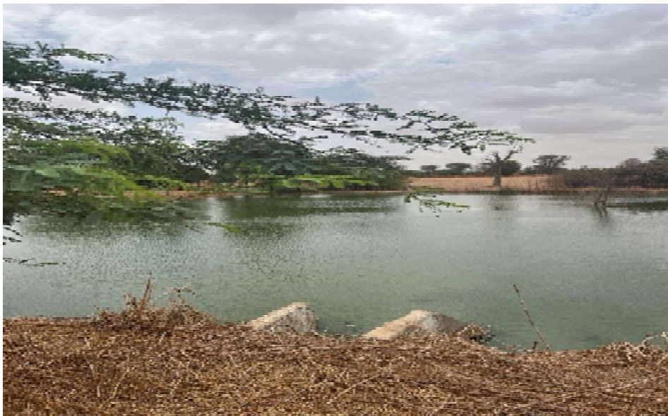
Photo 15 : Débordement du bassin d'infiltration des eaux usées traitées par la STEP de Diourbel
