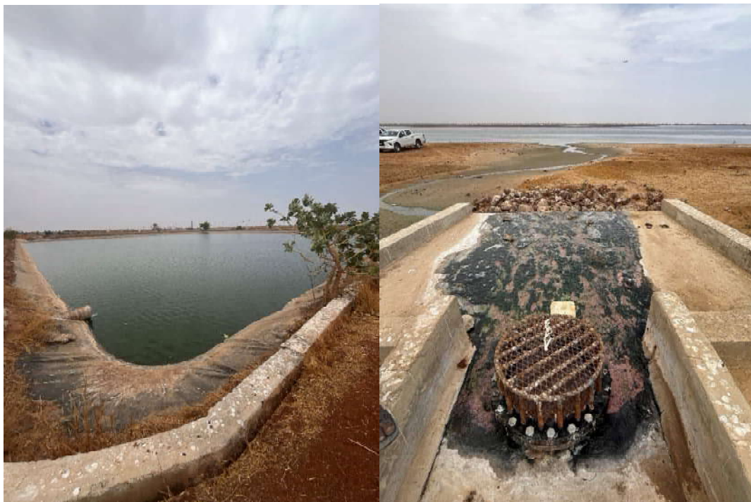
Photo 49 : Bassins de lagunage et exutoire final des eaux traitées de la STEP de Fatick
