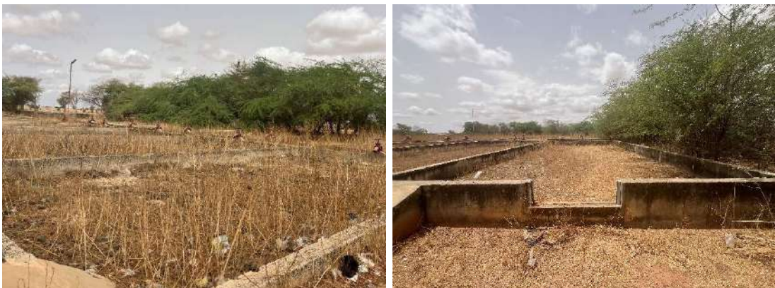
Photo 18 : Lits de séchage de la STBV de Mbacké
