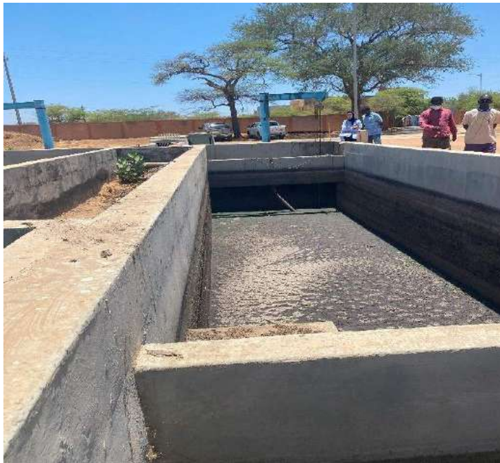
Photo 42 : Bassin de sédimentation de la STBV de Louga
