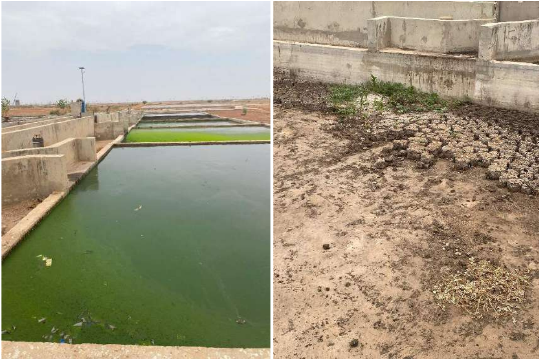
Photo 47 : Lits de séchage non plantés remplis (à gauche) et à sec (à droite) de la STBV de Fatick
