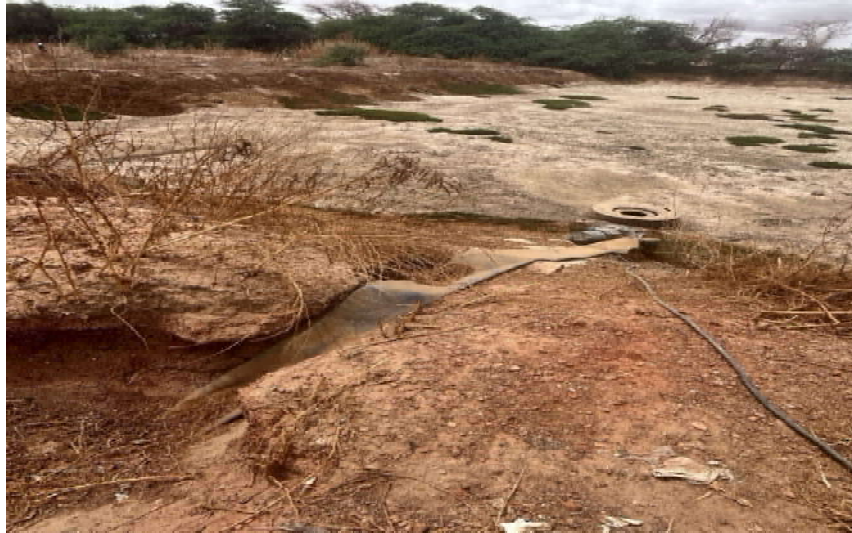
Photo 21 : Bassins d'infiltration de la STBV de Mbacké (2)
