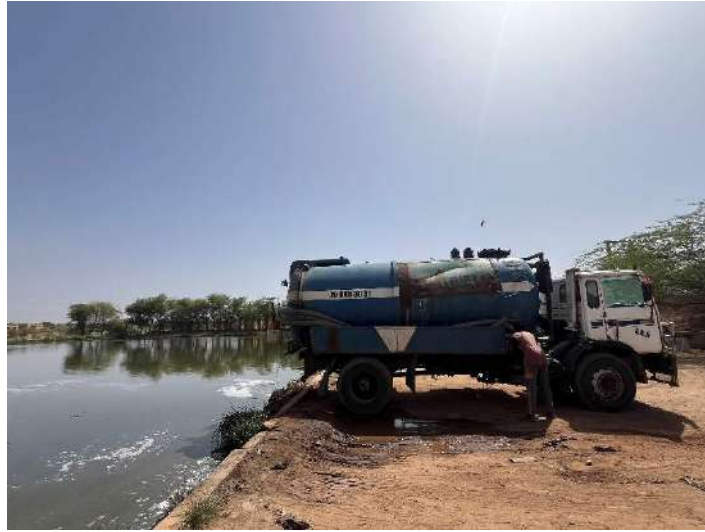
Photo 5 : Dépotage dans le bassin Gamou de la STBV de Tivaouane
