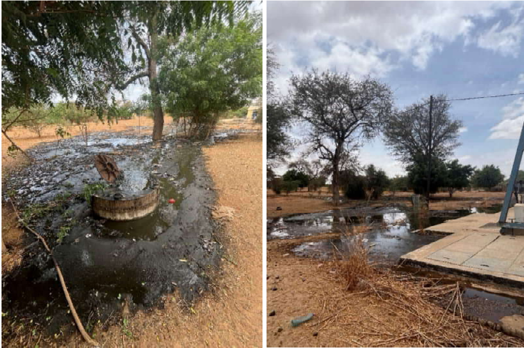
Photo 14: STEP envahie par les boues brutes de la STBV de Diourbel
