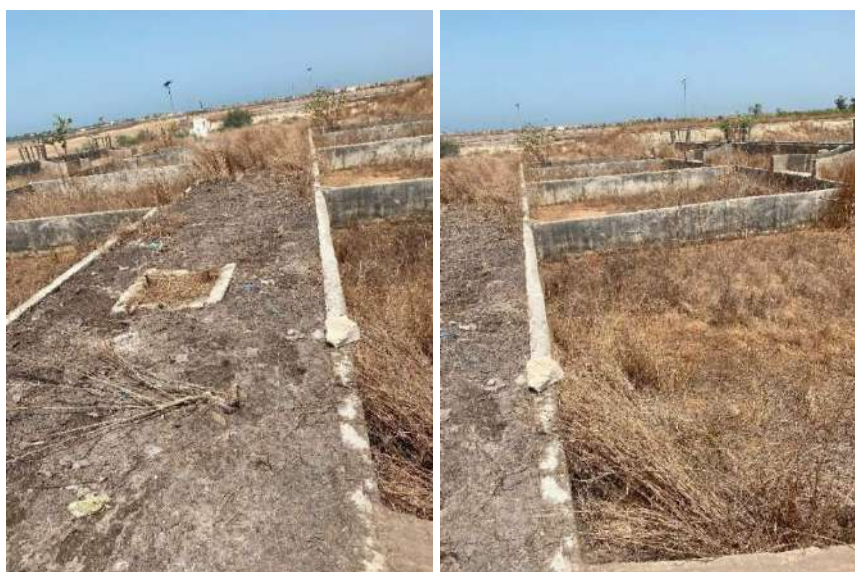
Photo 38 : Lits de séchage non plantés de la STBV de Joal
