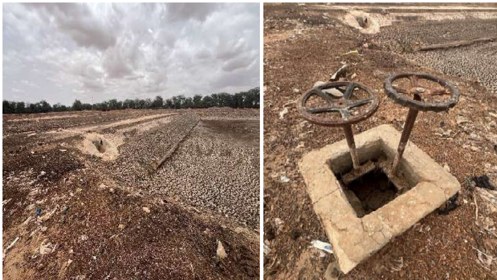
Photo 26 : Bassins d'infiltration de la STBV de Touba
