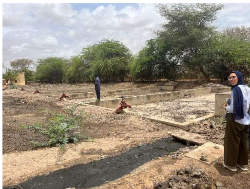
Photo 12 : Lits de séchage de la STBV de Diourbel
