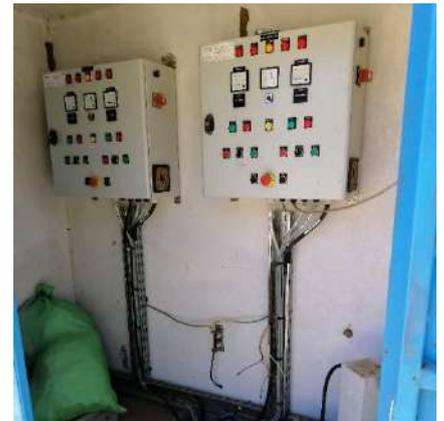
Photo 11 : Installations électriques en mauvais état à sécuriser, EDE, mai 2024
