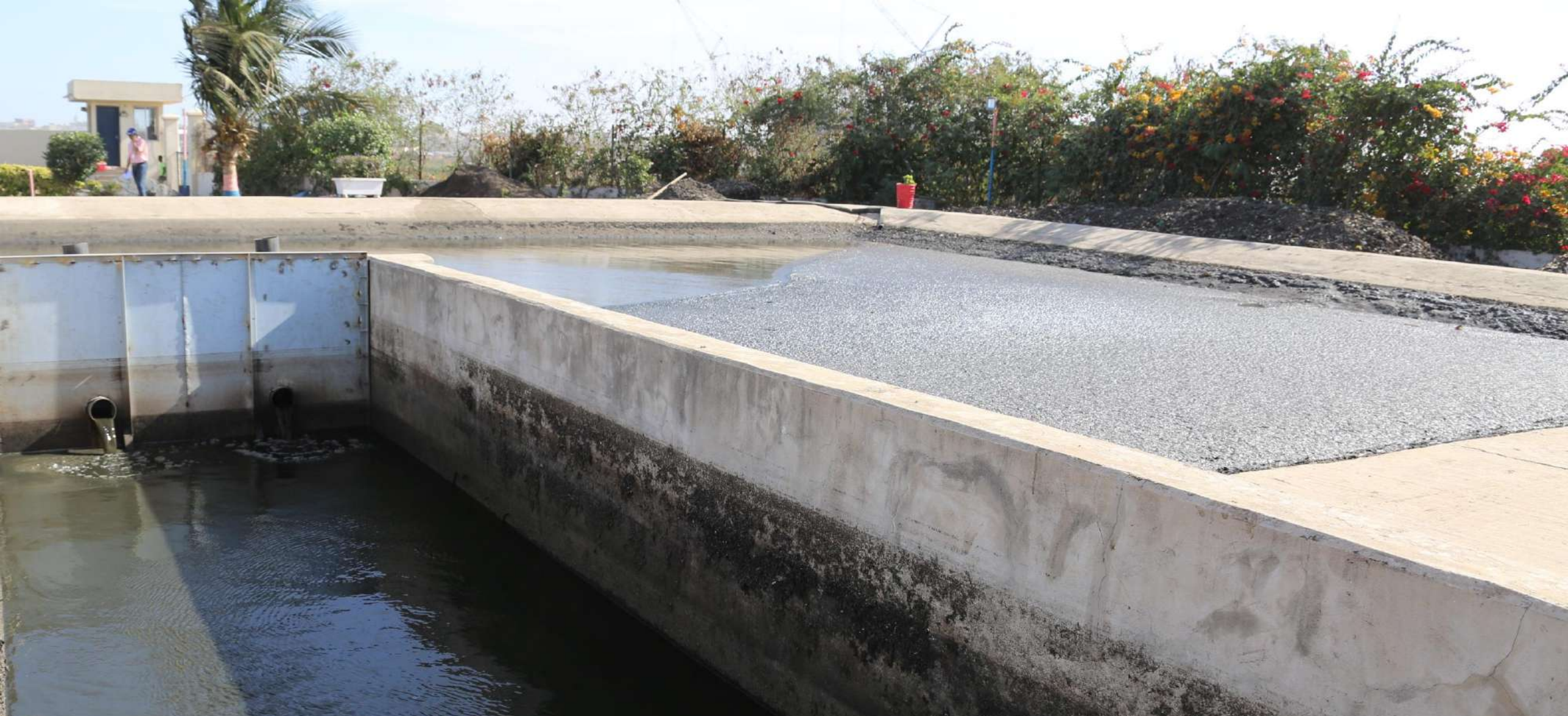
Cuve de dépotage, stations de traitement des boues de vidange des Niayes, Dakar. Mai 2018.
