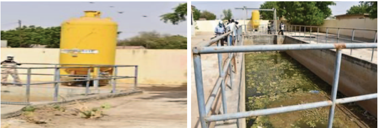
Photo 24: La station de pompage des eaux pluviales à Bambèye
