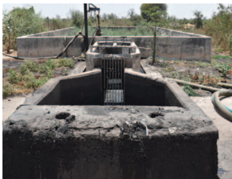
Photo 31: Station de Traitement des Boues de Vidange de Mbour
