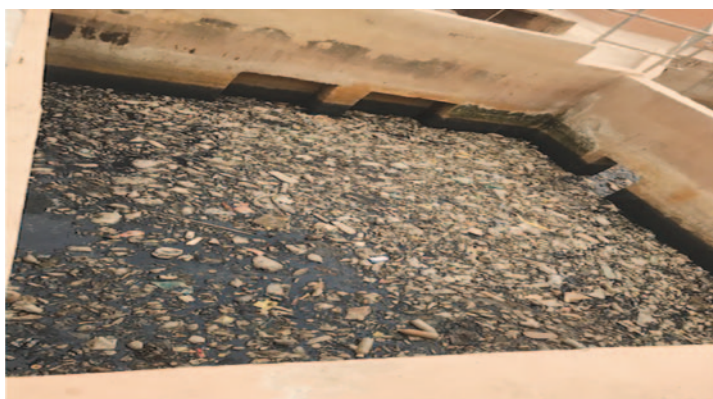
Photo 12 : Station de pompage des eaux pluviales de Dioukhop
