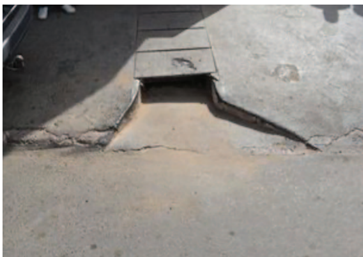
Photo 33: Station de Traitement et d'épuration des eaux usées de Saly
