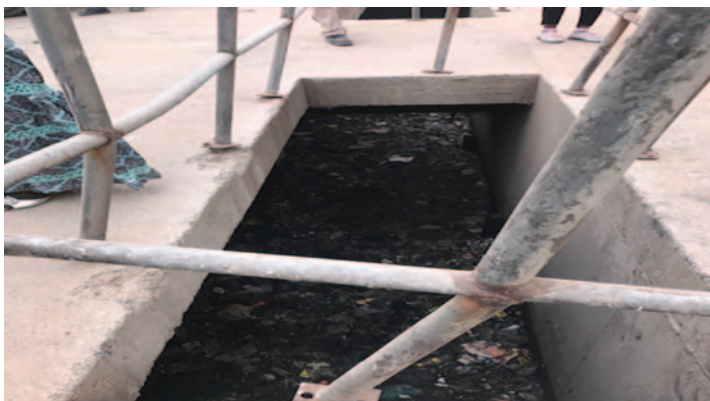
Photo 10 : STAP des eaux pluviales de SANDIKA
