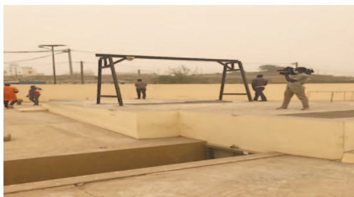
Photo 13 : Station de pompage des eaux pluviales de Gounass
