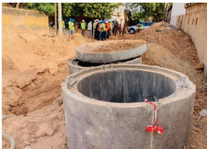
Photo 17 : Station de pompage des eaux usées à Tambacounda
