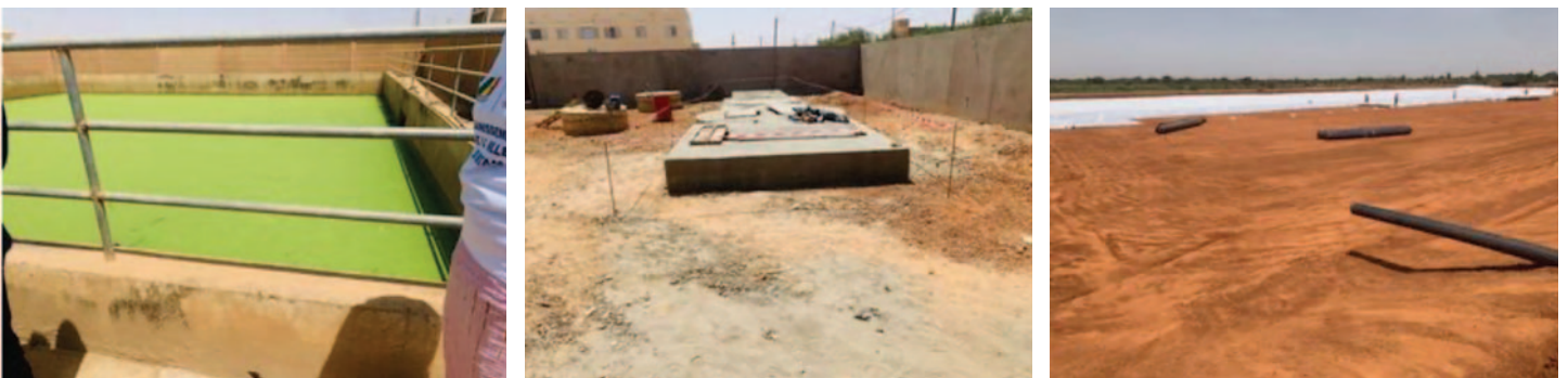
Photo 25: Les ouvrages d'assainissement et Travaux de la STEP de Matam
