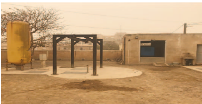
Photo 9 : Station de Pompage des eaux usées des Parcelles Unité 15
