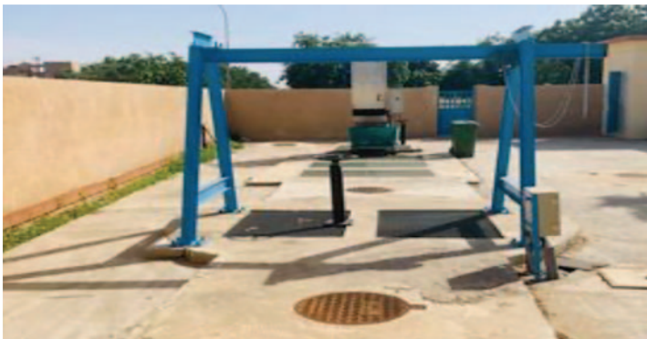
Photo 26: Station de pompage des eaux usées à Louga
