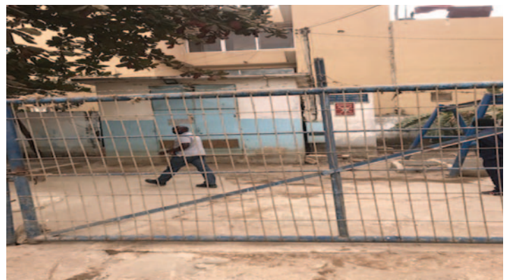
Photo 11 : STAP des eaux usées de DOMINIQUE
