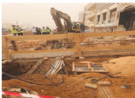
Photo 4 : Travaux de l'émissaire terrestre de la STEP Cambérène / BRT
